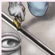
Applicazione del primer poliuretano PRIMER PS30.
