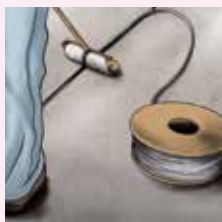
Posizionamento del cordolo DRAFIL.
