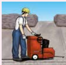
Réalisation de deux coupes longitudinales sur le vieux joint d'une profondeur de 5 cm à une distance du joint de 5 cm.
