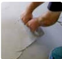
Résine de ragréage époxy-ciment bi-composant pour la réparation et le revêtement de sols en béton.
