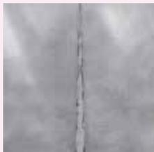
Le joint de construction est détérioré. Le scellement est absent, ce qui provoque une accumulation de poussière et de saleté. Les bords des plaques sont ébréchés et soumis à une détérioration progressive.
