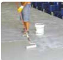
Résine époxy bi-composant transparente en émulsion aqueuse pour traitements de protection anti-poussière.
