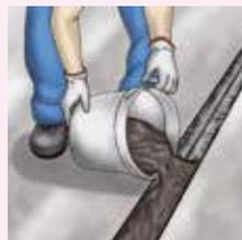
Après le mélange des 3 composants, coulage de RIPARAGIUNTI dans la section du joint de sol industriel. Finition superficielle à la spatule du produit encore frais.
