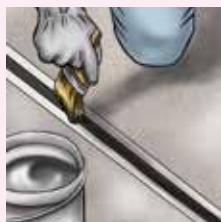
Apply polyurethane PRIMER PS30.
