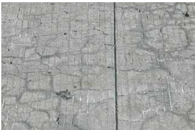
Propadanje uzrokovano reakcijom alkalnog agregata.
