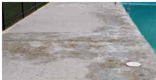
Učinak ispiranja betonske površine.
