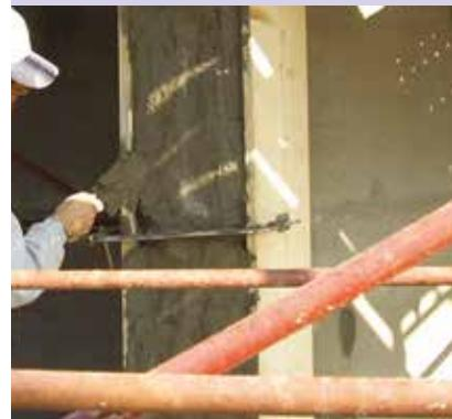
TIKSOTROPNI CEMENTNI MORTOVI ZA RESTAURACIJU BETONA
