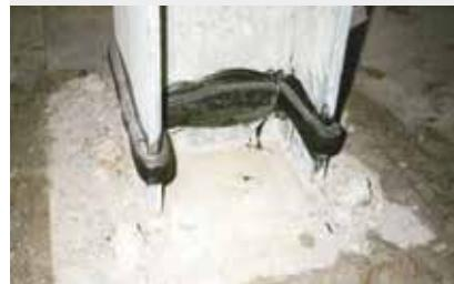
HIDROEKSPANZIVNI ZAUSTAVLJAČI VODE NA BAZI PRETHODNO HIDRATIZIRANOG BENTONITA ZA NANOŠENJE DODATNIH SLOJEVA
