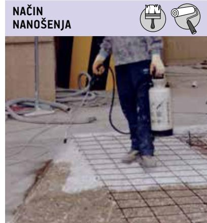
EPOKSIDNI TEMELJNI PREMAZI ZA BETONSKE PODLOGE
