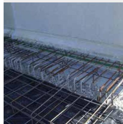
HIDROEKSPANZIVNI ZAUSTAVLJAČI VODE NA BAZI BENTONITA ZA NANOŠENJE DODATNIH SLOJEVA
