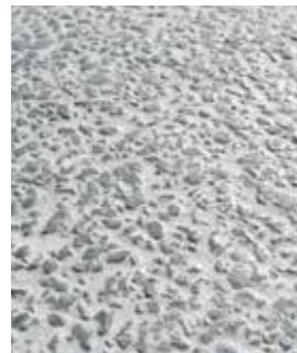
■ Dotrajali sloj stare podne površine uklonjen je frezom, a zatim je položena drenažna asfaltna traka.
