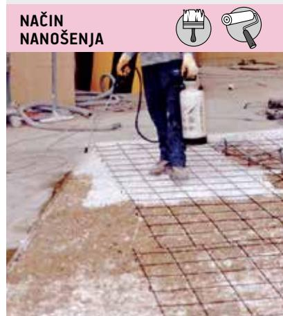
EPOKSIDNI TEMELJNI PREMAZI ZA BETONSKE PODLOGE
