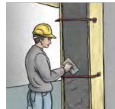
■ Surfaçage, finition et protection avec CONCRETE FINISHER.
