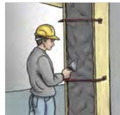
■ Reconstruction de la section manquante avec les mortiers thixotropes FLUECO (FLUECO 40T, 55T ou 80T).
