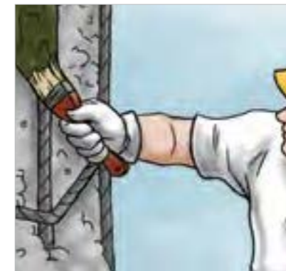
■ Traitement des fers d'armature avec DRACOSTEEL.
