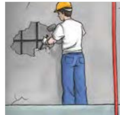
■ Élimination d'éléments qui ne sont plus solidaires du béton endommagé.
