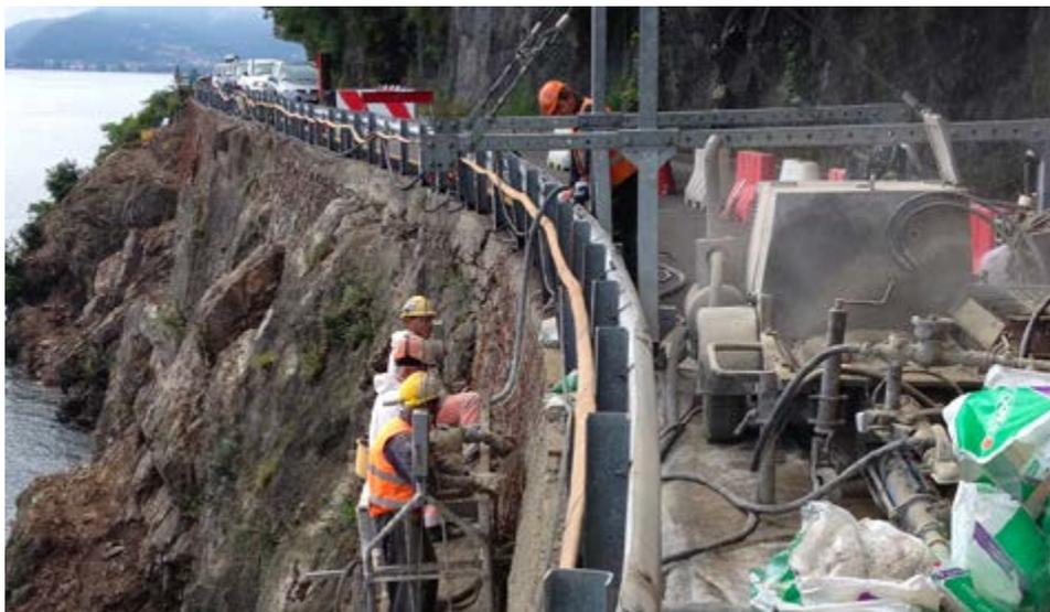
L'intervento, commissionato da ANAS Piemonte, prevede l'adeguamento delle opere di sostegno per il successivo allargamento della sede stradale. FLUECO 55T è stato impiegato per il consolidamento della parete di
