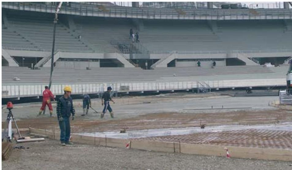
Additivazione del calcestruzzo per la realizzazione della pavimentazione per le Olimpiadi invernali Torino 2006 con FLUIPAV 501 R.
