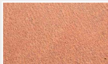
Rivestimento del piano di calpestio in asfalto della pista ciclabile con il rivestimento protettivo antiusura a base di resine acriliche BITUMFLEX COLOR nella colorazione rossa – superficie complessiva ca. 3000 mq.
