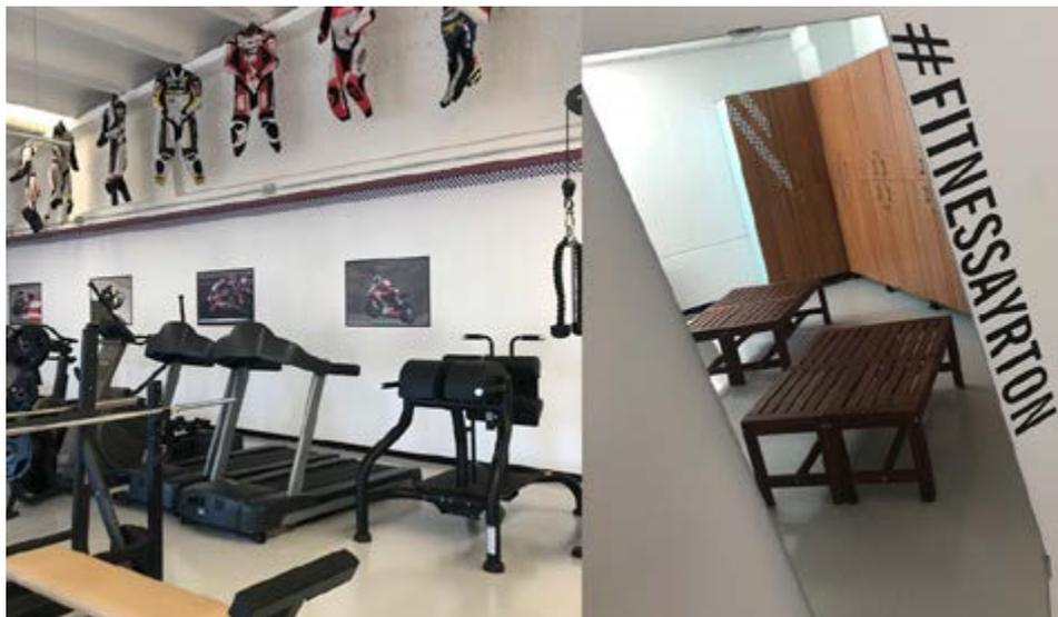
Il rivestimento della pavimentazione interna della sala attrezzi è stato realizzato in rivestimento resinoso, mentre gli spogliatoi e le docce, compreso il piatto doccia, sono stati realizzati impiegando il microrivestimento tecnico
