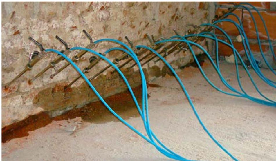
Risanamento della struttura muraria tramite iniezioni di barriera chimica per il blocco dell'umidità di risalita SANOFAR I e rivestimento delle pareti interne con intonaco
