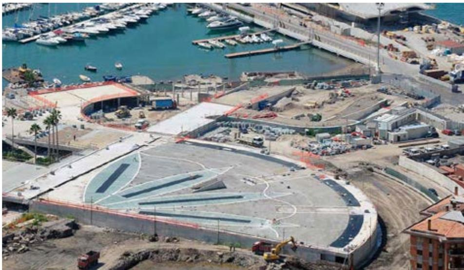
La vasta superficie della piazza principale e la struttura di fondazione sono esposte ad atmosfere aggressive ricche di sali e sono soggette all'aggressione degli agenti chimici contenuti nelle acque di falda. L'impermeabilizzazione è
