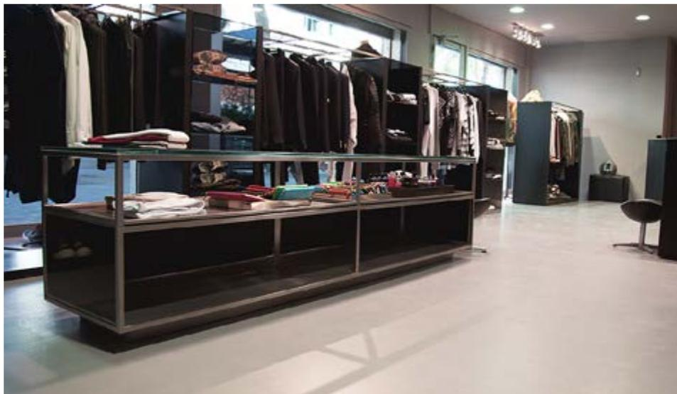
Il rivestimento della pavimentazione interna del negozio è stato realizzato impiegando un sistema resinoso continuo per superfici architettoniche DRACOFLOOR, in una speciale
