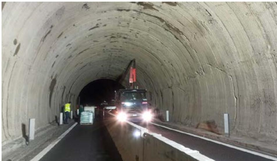
Le fasi operative dell'intervento di ripristino hanno previsto la scarifica dello strato corticale di calcestruzzo ammalorato al fine di realizzare una superficie di fondo sana, compatta e regolare, con buone caratteristiche "aggrappanti" senza scoprire le armature sottostanti; la sigillatura delle microfessure e delle lesioni strutturali superficiali presenti tramite iniezioni ravvicinate a bassa pressione di resina
