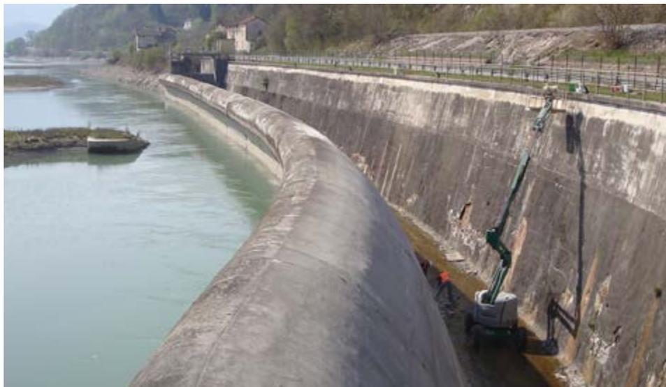
Consolidamento delle pareti della diga attraverso iniezioni della resina acrilica flessibile e idroespandibile a gel time regolabile DRACOGEL GT2.
