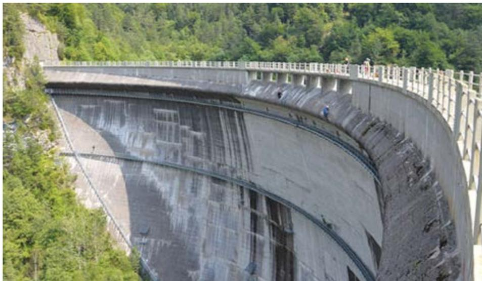
Intervento di consolidamento e impermeabilizzazione della struttura in c.a. tramite iniezione di DRACOGEL GT2 e sigillatura dei giunti freddi della diga, e ripristino dello
