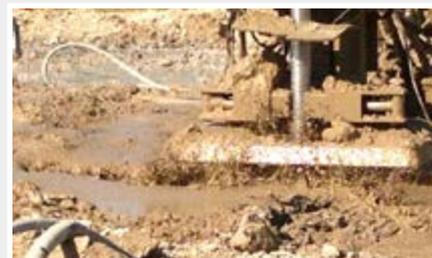
Consolidamento e riduzione della permeabilità idraulica del terreno sottostante il tratto ferroviario Trieste-Venezia e Cervignano-Udine tramite iniezione di legante confezionato con DRACOSOIL.
