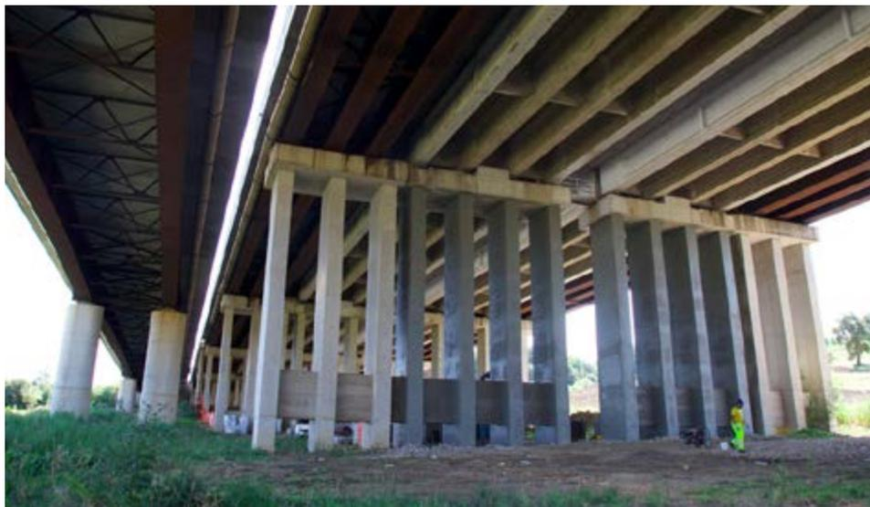
Trattamento ferri esposti con DRACOSTEEL. Ripristino del calcestruzzo con malta fibroarmata FLUECO additivata con PRESIDIO SRA. A completamento del ripristino la superficie è stata trattata con il rivestimento ACRIFLEX.
