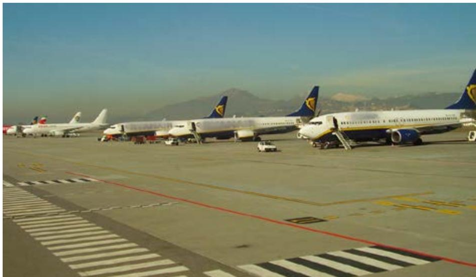
Getto di pista aeroportuale in calcestruzzo confezionato con FLUIPAV 501 e sigillatura dei giunti di costruzione e contrazione con la resina epossipoliuretana flessibile chimico-resistente EPOJOINT.
