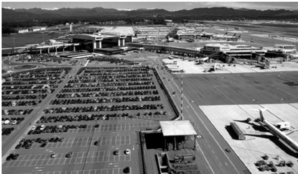
Il calcestruzzo impiegato per la realizzazione della pavimentazione esterna è stato additivato con i superfluidificanti acrilici della linea DRACRIL. I giunti di
