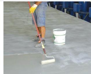
La resa del ciclo applicativo è indicativa e varia in funzione del tipo di supporto e delle condizioni ambientali. I valori specificati sono calcolati a una temperatura compresa tra +15 e +25°C, umidità relativa del 50% circa su supporto compatto e adeguatamente preparato.
