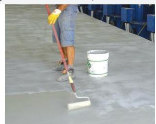
Učinak ciklusa nanošenja indikativan je i razlikuje se ovisno o vrsti podloge i uvjetima okoline. Navedene su vrijednosti izračunate pri temperaturi između +15 i +25 °C i relativnoj vlažnosti od pribl. 50 % na kompaktnoj i prikladno pripremljenoj podlozi.
