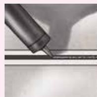
■ Application du mastic-colle époxy-polyuréthanique flexible **EPOJOINT**.
