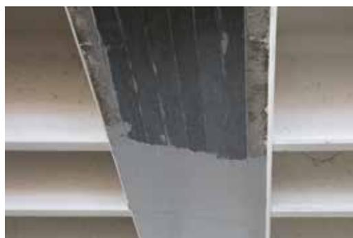
**FASE 4** Applicazione dell'adesivo ARMOFIX MTX sulle lamelle fino a totale copertura
