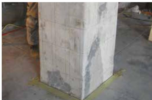
*Ricostruzione volumetrica del pilastro con malta fibrorinforzata della linea FLUECO e arrotondamento degli spigoli*
