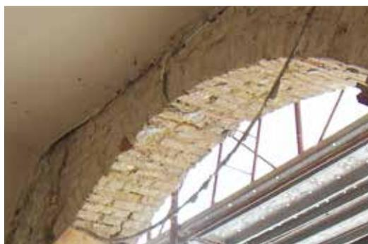
Arco prima dell'intervento: rimozione completa di intonaci o rivestimenti esistenti.
