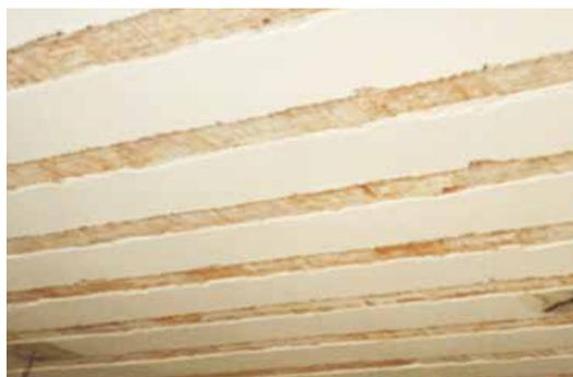
**FASE 1** Demolizione del fondello in laterizio, trattamento dei ferri e ricostruzione con malta fibrorinforzata
