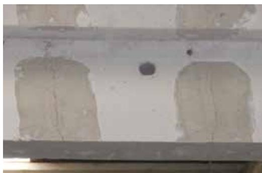
*Rimozione del rivestimento esistente, arrotondamento degli spigoli e pulizia delle superfici*
