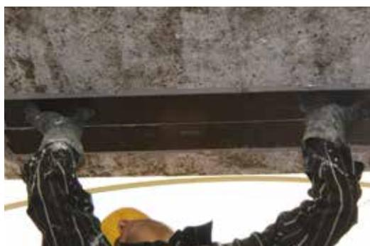
**FASE 3** Posa in opera delle lamelle ARMOSHIELD CFK sullo strato di resina fresco
