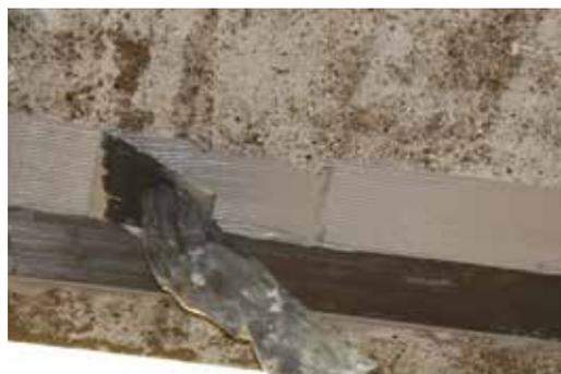
**FASE 2** Applicazione dell'adesivo epossidico ARMOFIX MTL specifico per l'applicazione delle lamelle
