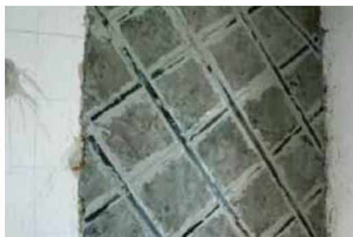
*Controventi con lamelle pultruse in fibra di carbonio ARMOSHIELD CFK*
