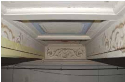
**FASE 1** Realizzazione della fessura per l'alloggiamento della lamella.
