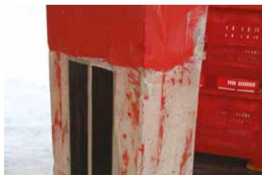
**FASE 2** Applicazione dell'adesivo epossidico di incollaggio ARMOFIX MTL e delle lamelle ARMOSHIELD CFK
