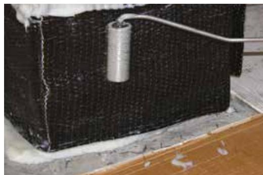
*Posa in opera del tessuto ARMOSHIELD C-SHEET e impregnazione con resina epossidica ARMOFIX MTX*
