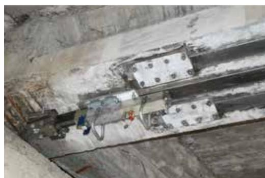
**FASE 4** Pretensionamento della lamella con martinetto idraulico
