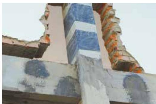
**FASE 2** *Cerchiatura del pilastro con tessuti in fibra di carbonio ARMOSHIELD C.*
