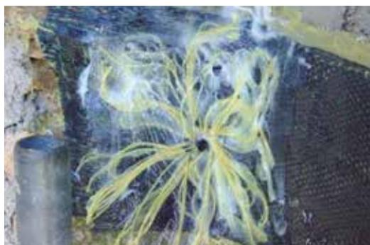
**FASE 3** *Apertura e fissaggio del fiocco con ARMOFIX MTX.*
