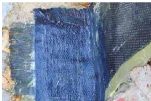
**FASE 4** Porzione di tessuto in fibra di carbonio ARMOSHIELD C applicato sul fiocco a protezione del connettore.
