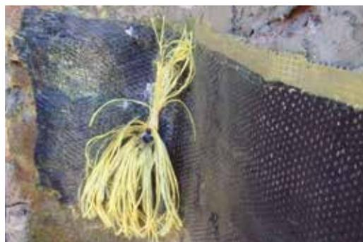
**FASE 2** Inserimento del connettore aramidico ARMOGRIP BC all'interno del foro riempito con la resina ARMOFIX MTX.
