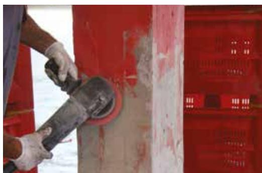
**FASE 1** Rimozione del rivestimento esistente, pulizia, arrotondamento spigoli e stesura primer
