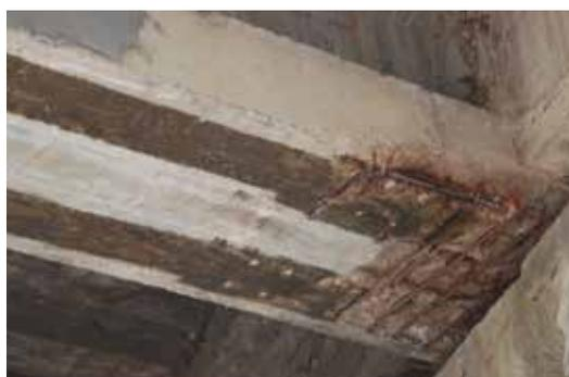
**FASE 1** Realizzazione dei fori per il fissaggio delle piastre e applicazione del primer ARMOPRIMER 100
