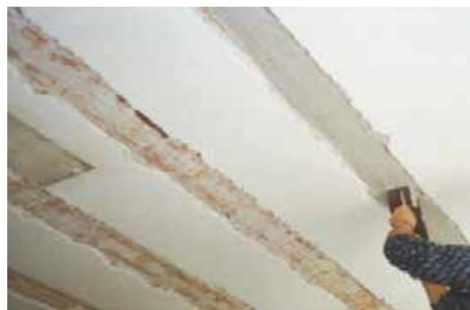
**FASE 2** Applicazione della resina epossidica ARMOFIX MTL per l'incollaggio delle lamelle
