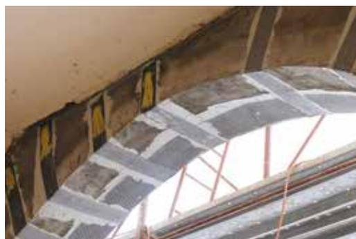
Applicazione dei tessuti ARMOSHIELD C-SHEET all'intradosso e fasciature fissate con i connettori aramidici ARMOGRIP.
