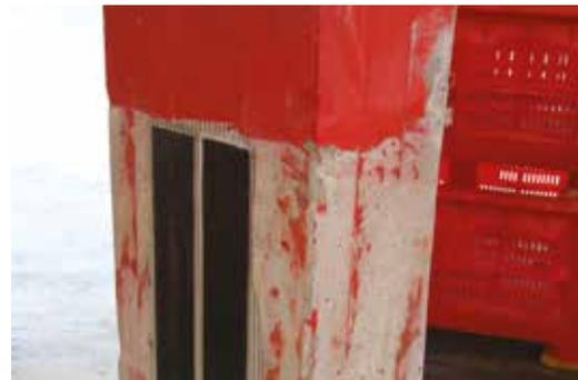
**PHASE 2** *Application de la colle époxy ARMOFIX MTL et des bandes ARMOSHIELD CFK*
