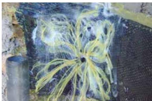
**PHASE 3** *Ouverture en éventail et fixation de la mèche avec la résine époxy ARMOFIX MTX*
