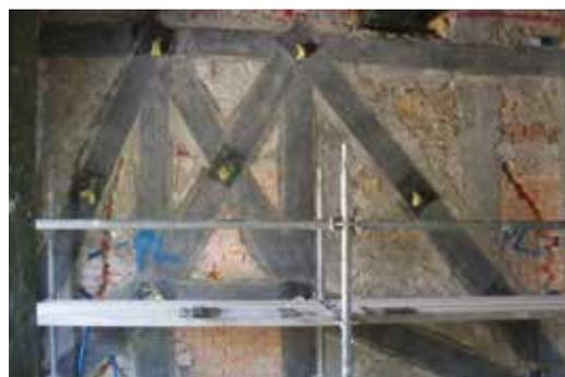
Mur renforcé sur les deux côtés avec les tissus en fibre de carbone ARMOSHIELD C positionnés selon le schéma du projet
