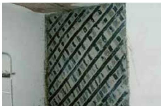
*Contreventements avec des tissus unidirectionnels en fibre de carbone ARMOSHIELD C*
