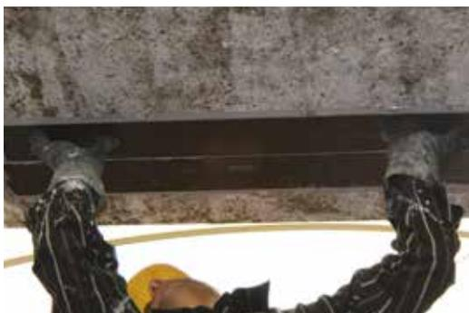
**PHASE 3** Pose des bandes ARMOSHIELD CFK sur la couche de résine fraîche
