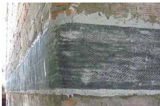
Frettage avec les tissus unidirectionnels en fibre de carbone ARMOSHIELD C
