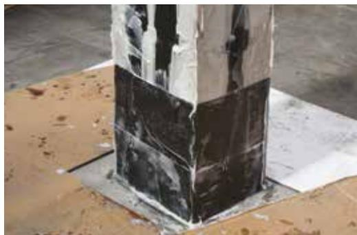
**PHASE 3** *Pose des tissus unidirectionnels ARMOSHIELD C-SHEET sur la résine ARMOFIX MTX et imprégnation*
