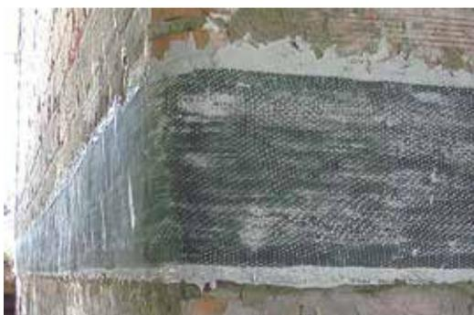
*Frettage avec des bandes unidirectionnelles : détail de l'angle arrondi*
