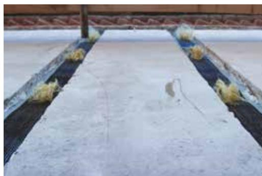
Pose des tissus en fibre de carbone ARMOSHIELD C sur les couloirs de mortier et insertion des connecteurs ARMOGRIP
