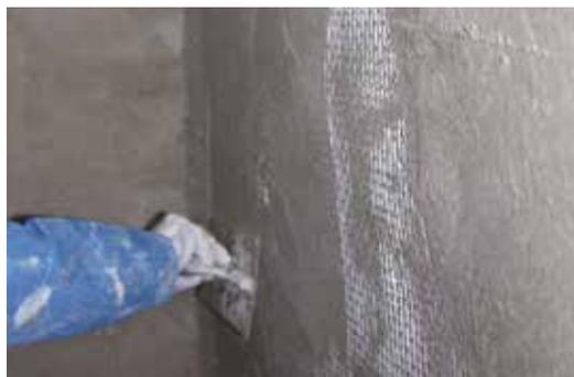
*Application du treillis entre deux couches de mortier ARMOTECH MONO*
