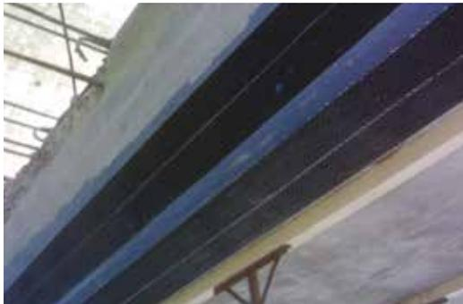
*Application des tissus en fibre de carbone ARMOSHIELD-C à l'intrados de la poutre*
