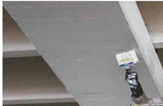
*Finition de protection avec de l'enduit ou un autre revêtement en ciment ou résine*
