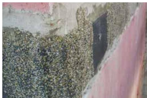
Détail du saupoudrage final avec du sable au quartz pour favoriser la pose de l'enduit
