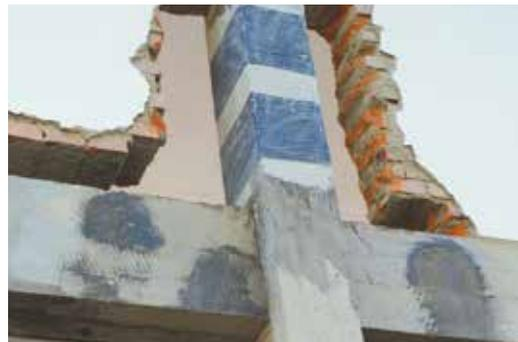
**PHASE 2** Frettage du pilier avec les tissus en fibre de carbone ARMOSHIELD C
