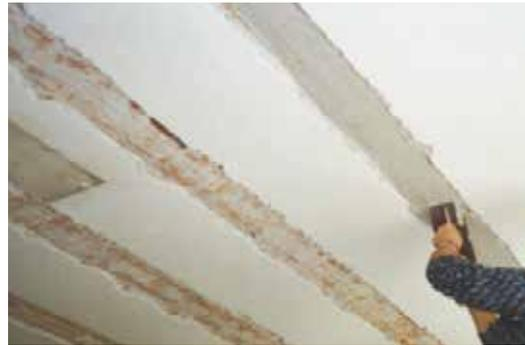
**PHASE 2** Application de la résine époxy ARMOFIX MTL pour le collage des bandes
