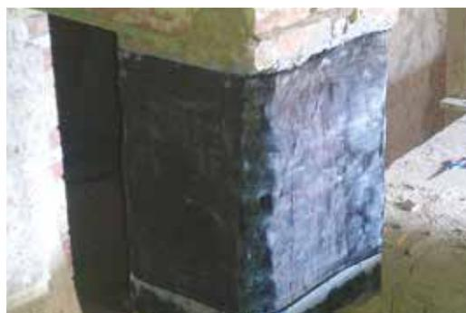
*Frettage du pilier avec les tissus en fibre de carbone ARMOSHIELD C*
