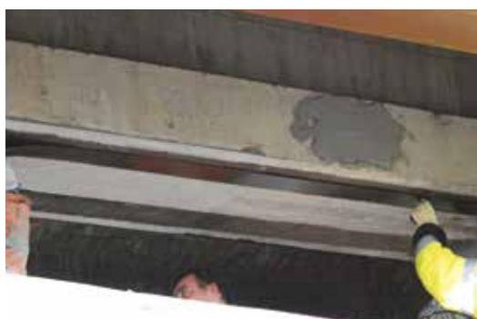
**PHASE 3** Application de la bande ARMOFIX MTL sur la longueur de la poutre
