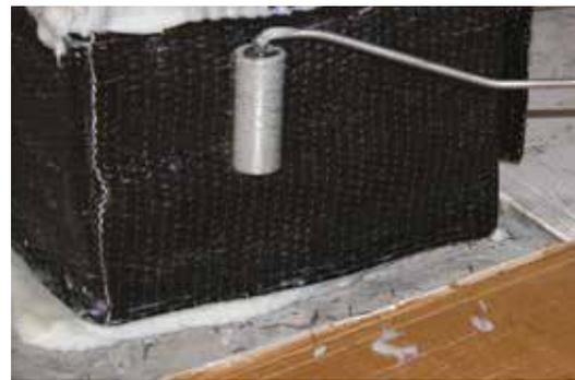
*Pose du tissu ARMOSHIELD C-SHEET et imprégnation avec la résine époxy ARMOFIX MTX*
