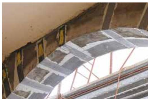
*Application des tissus ARMOSHIELD C-SHEET à l'intrados et bandes fixées avec les connecteurs en aramide ARMOGRIP*
