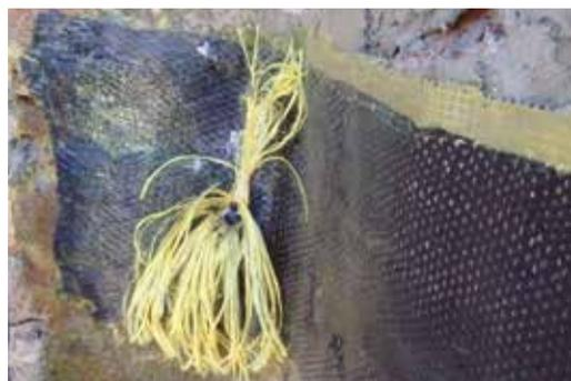
**PHASE 2** *Introduction du connecteur en aramide ARMOGRIP BC à l'intérieur du trou rempli de résine ARMOFIX MTX*
