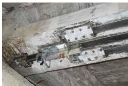
**PHASE 4** Pré-tension de la bande avec vérin hydraulique
