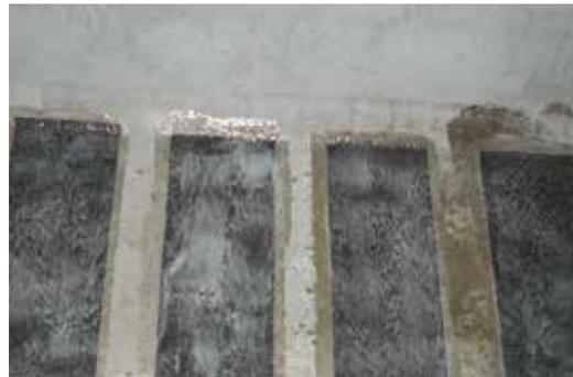
*Application des tissus ARMOSHIELD C-SHEET sur la couche de résine ARMOFIX MTX*
