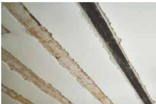
**PHASE 3** Application des bandes ARMOSHIELD CFK sur la couche de résine encore fraîche
