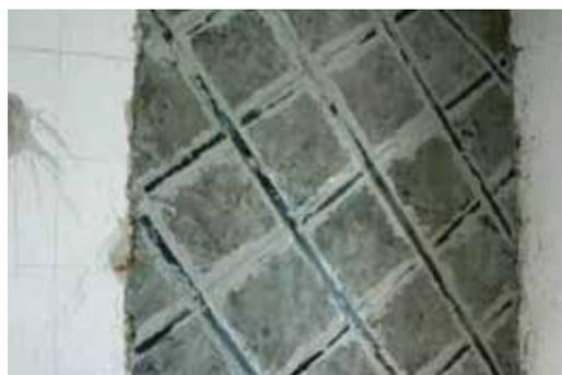
*Contreventements avec des bandes pultrudées en fibre de carbone ARMOSHIELD CFK*
