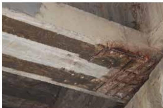
**PHASE 1** Réalisation des trous pour la fixation des plaques et application du primaire ARMOPRIMER 100
