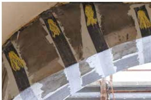
*Détail des frettages en « U » et connecteurs en aramide ARMOGRIP*
