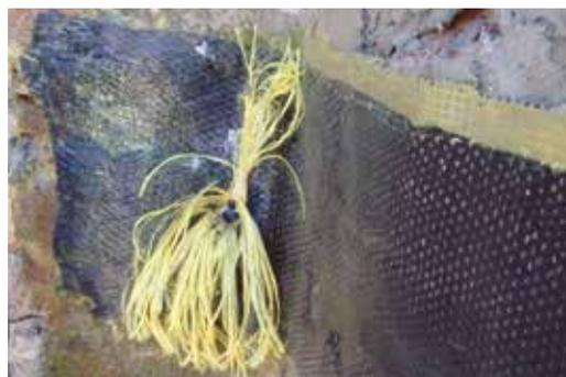
**PHASE 2** Insertion du connecteur en aramide ARMOGRIP BC
