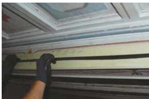
**PHASE 3** Insertion de la bande ARMOSHIELD CFK
