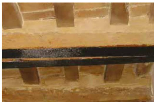
*Application des tissus en fibre de carbone ARMOSHIELD-C SHEET à l'intrados de la poutre*
