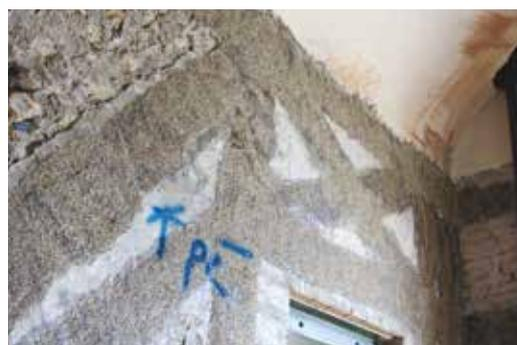
Saupoudrage avec du sable au quartz pour favoriser la pose de l'enduit
