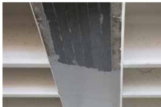
**PHASE 4** Application de la colle ARMOFIX MTX sur les bandes jusqu'à les recouvrir totalement
