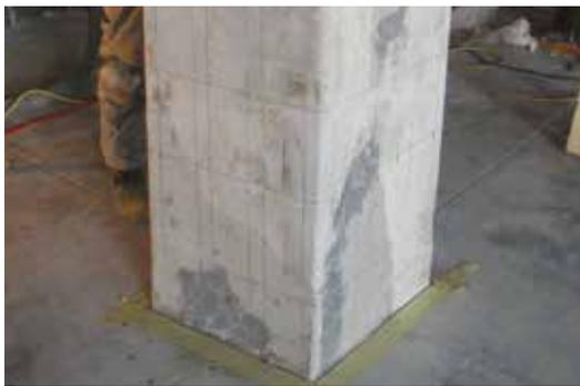
*Reconstruction volumétrique du pilier avec un mortier fibré de la ligne FLUECO et arrondi des arêtes*
