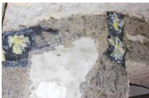
Raccordements avec double connecteur en aramide ARMOGRIP
