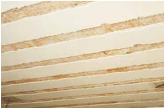
**PHASE 1** Démolition du fond en brique, traitement des fers et reconstruction avec du mortier fibré
