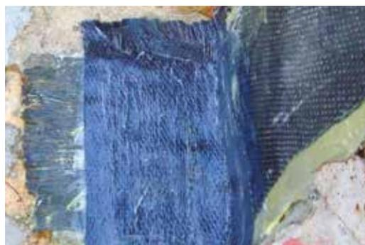
**PHASE 4** Portion de tissu en fibre de carbone appliqué sur la mèche pour protéger le connecteur
