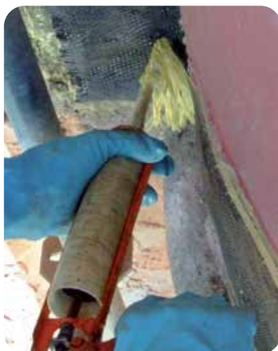
2. RIEMPIMENTO E IMPREGNAZIONE CON RESINA EPOSSIDICA
